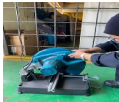
Gambar 5. Pemotongan besi bagi pembinaan kerangka utama
